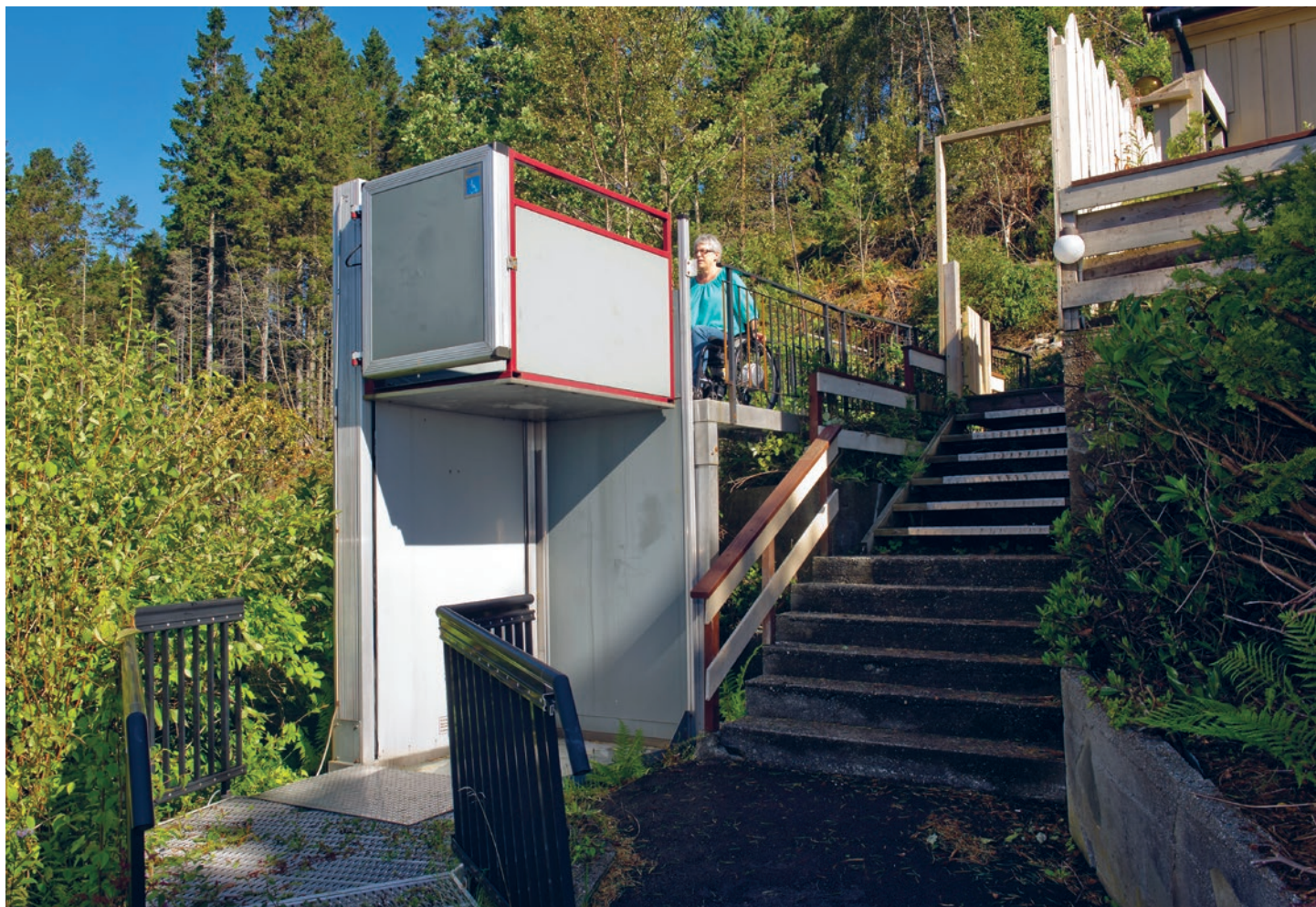
Løfteplattform gir trinnfri atkomst i bratt terreng. Foto: Marit Hommedal
