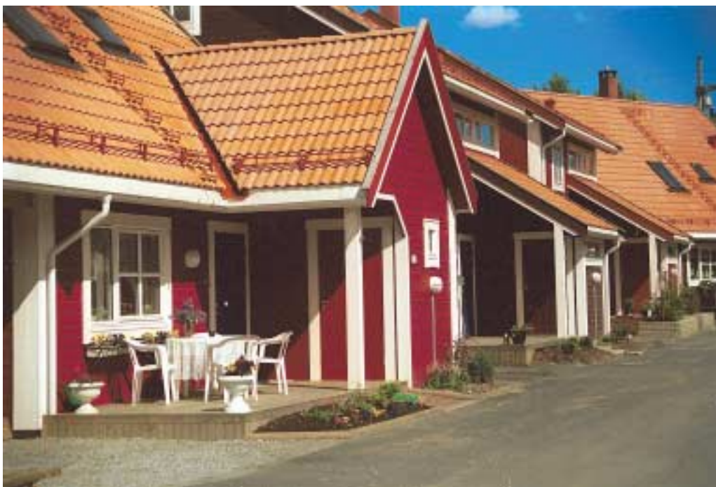
Eneboligene har trinn opp til inngangen. Dette skal ikke forekomme i et boligkompleks med livsløpsstandard.
