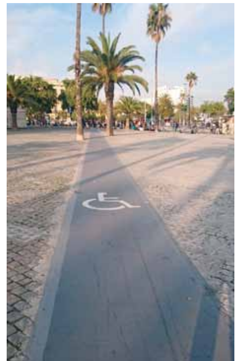
TILRETTELAGT: Langs havnepromenaden var det anlagt eget kjørefelt for rullestoler over brosteinen.
