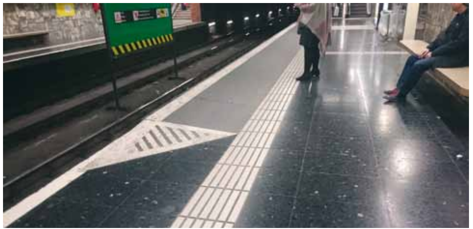
ENKEL LØSNING: Gulvet på metrostasjonen er hevet for å nå togåpningen, en midlertidig løsning i påvente av oppgradering.
