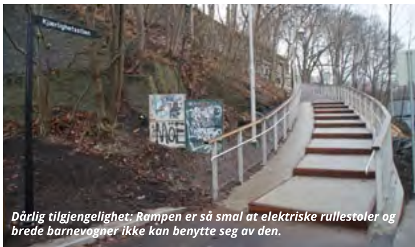
For bratt: Tilgjengelighetsrådgiver Birger Nymo konstaterer at rampen er både for smal og for bratt.
