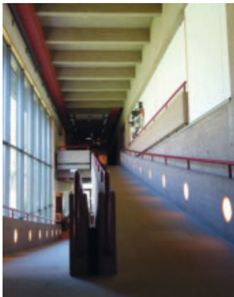
Rampe innvendig i Bryggen Museum. Bygget i 1976, før hvileplan på rampe var aktuelt.
