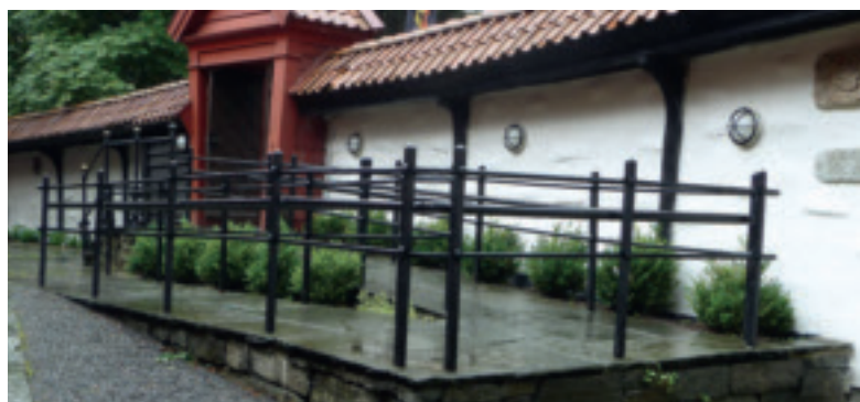
Rampe ved Bryggen i Bergen; inngang til Schøtsstuene
