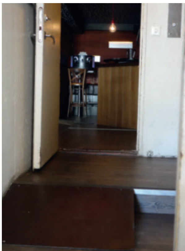
OBS! Ved inngangen til dette skjenkestedet bør en være både forsiktig og edru.....
