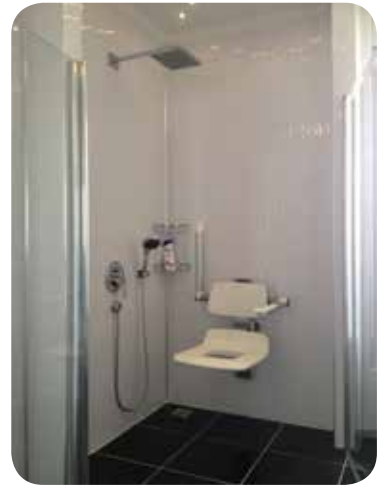
Vegghengt og regulerbar dusjstol var montert på begge bad.
