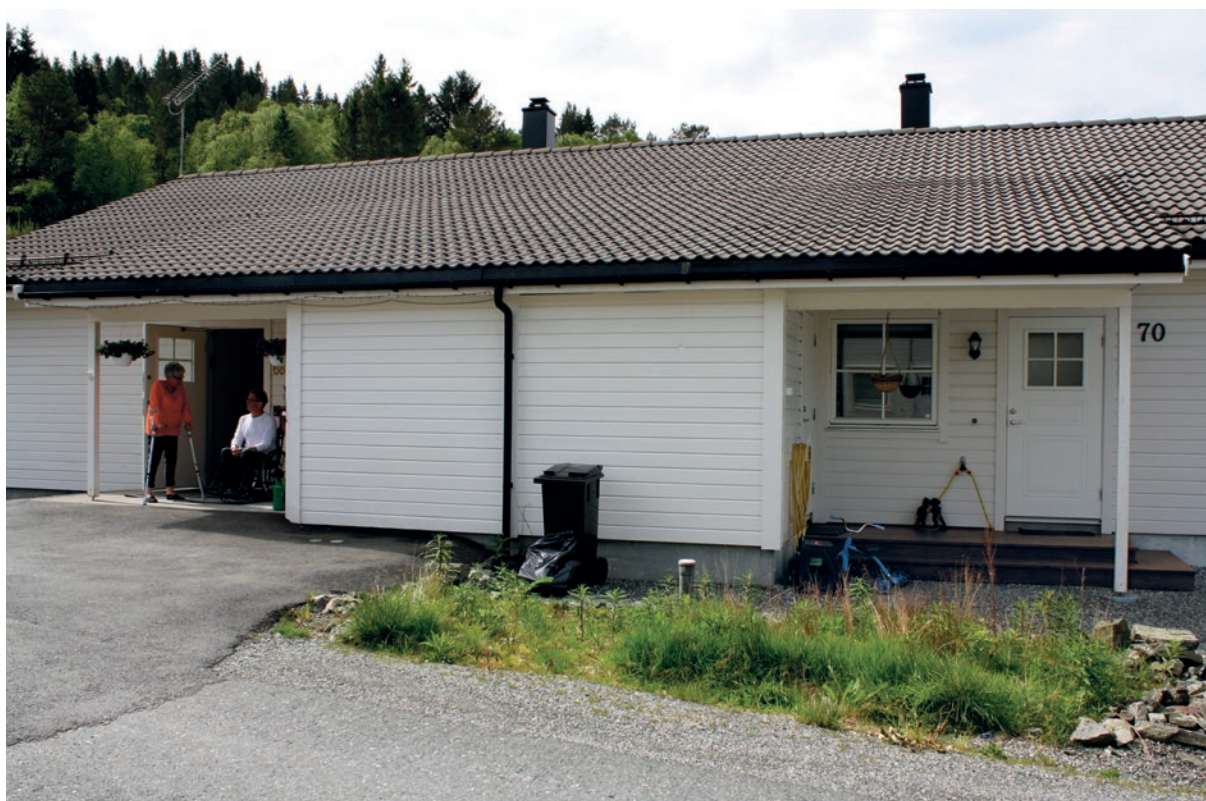
Rekkehus med to boliger. Begge ble planlagt med trapp. Boligen til venstre er gjort trinnfri ved å heve terrenget til samme nivå som inngangsplanet. Hvorfor bygges ikke alle boliger med trinnfri inngang? Foto: Guri Henriksen
