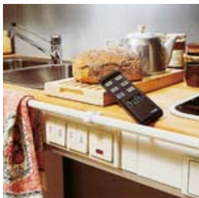
Fig 14. Benk og skap reguleres i høyden med brytere eller fjernkontroll.
